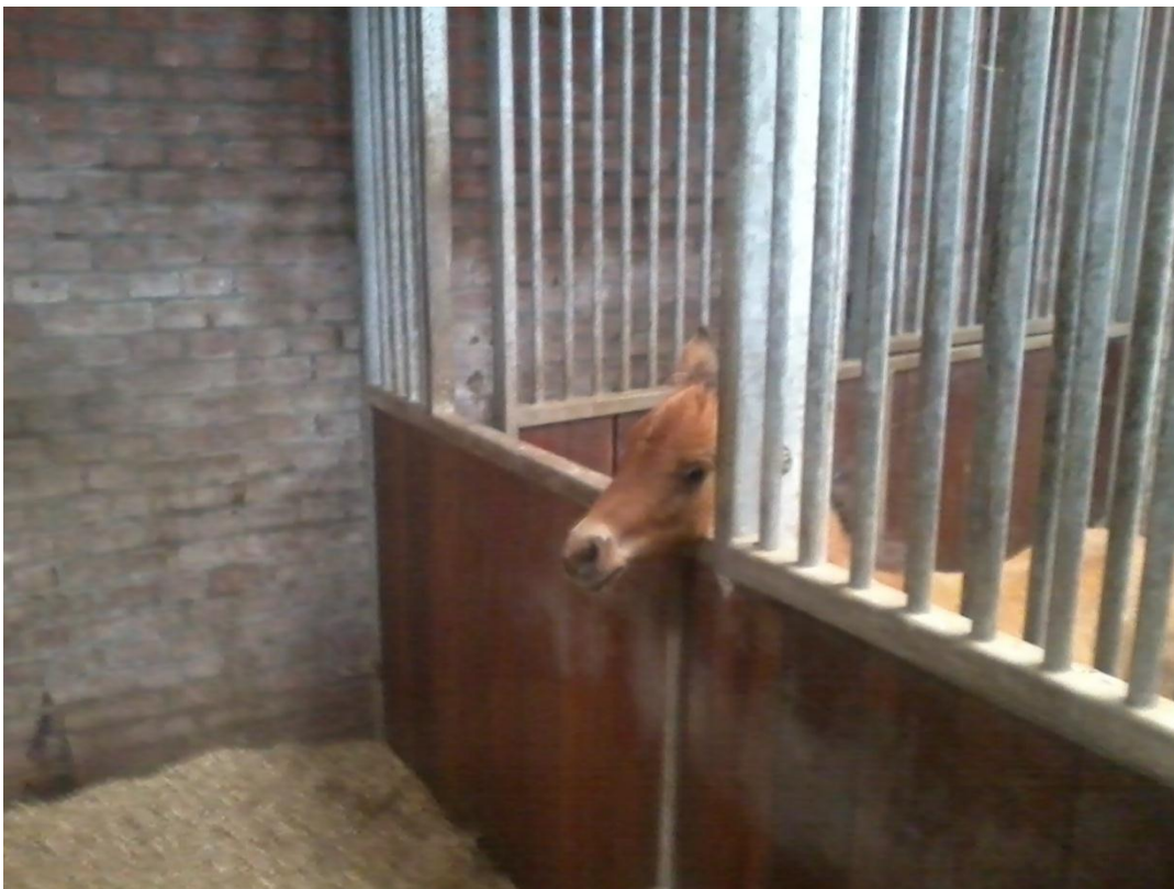
Foto 2 Zijwanden stallen kunnen zijn verplaatsbaar. Maak variatie in stalgrootte en communicatie tussen burens mogelijk.
